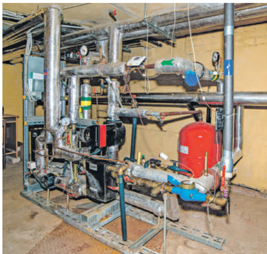
Pavyzdinčiai sutvarkytas namo šilumos punktas
